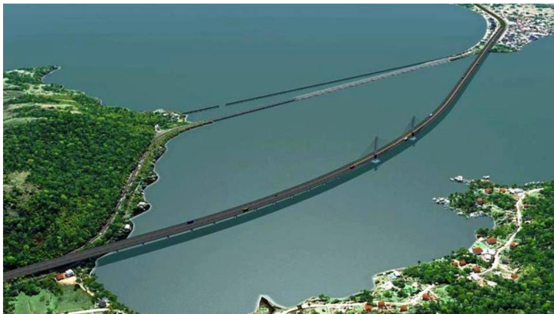
FIGURA 6 - BR-101 SUL – PONTE SOBRE O CANAL DE LARANJEIRAS, LAGOA DO IMARUÍ
