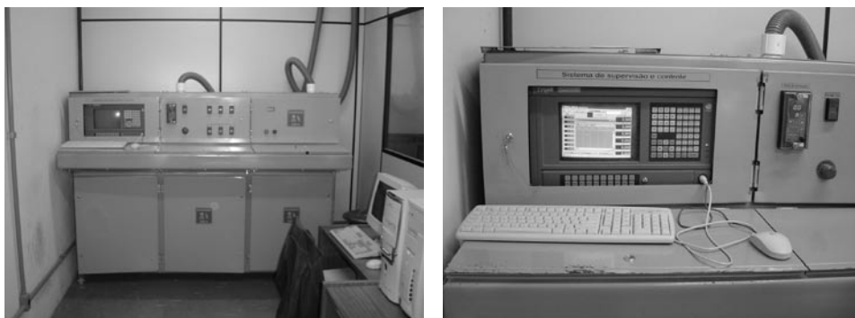
Figura 8.31 – Quadro de comando e proteção, sistema de aquisição de dados
