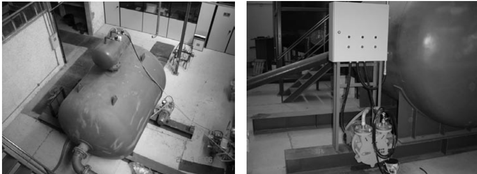
Figura 8.33 – Reservatório de sucção, balão de controle e a bomba de vácuo e quadro elétrico
