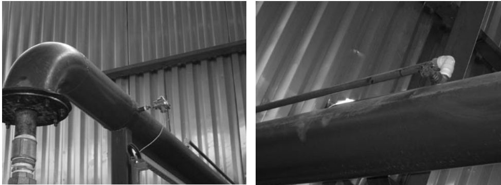
Figura 8.29 – Tubulação de recalque R, medida de temperatura com PT-100 e válvula de sangria
