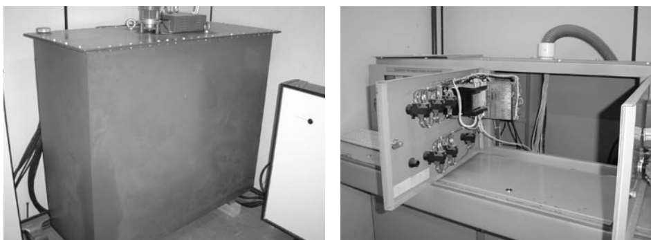
Figura 8.32 – Regulador de tensão e transdutor de Watt instalado no quadro de comando
