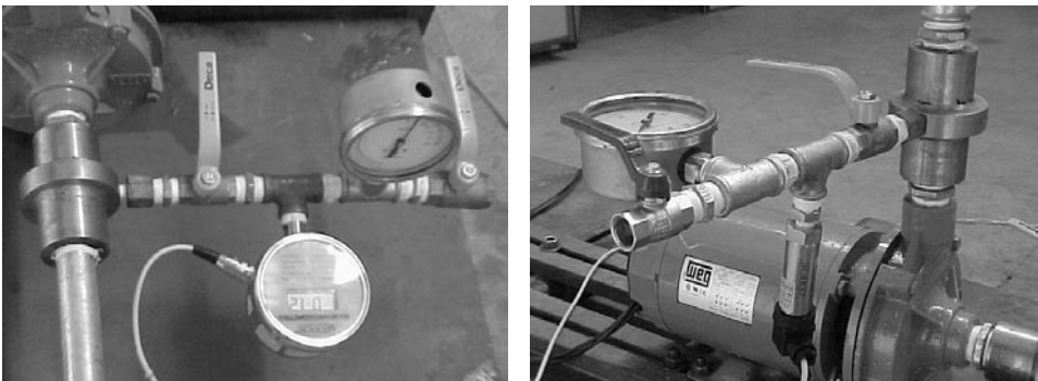
Figura 8.28 – Anéis piezométricos e transdutores de pressão na entrada e saída da bomba
