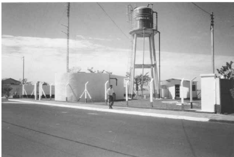
Figura 3.23: Reservatórios apoiado e elevado
