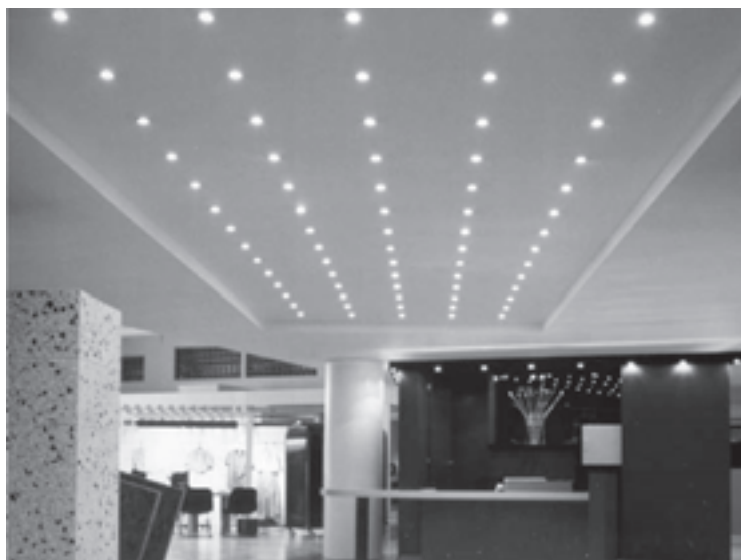
Figura 33 – Sistema de iluminação
