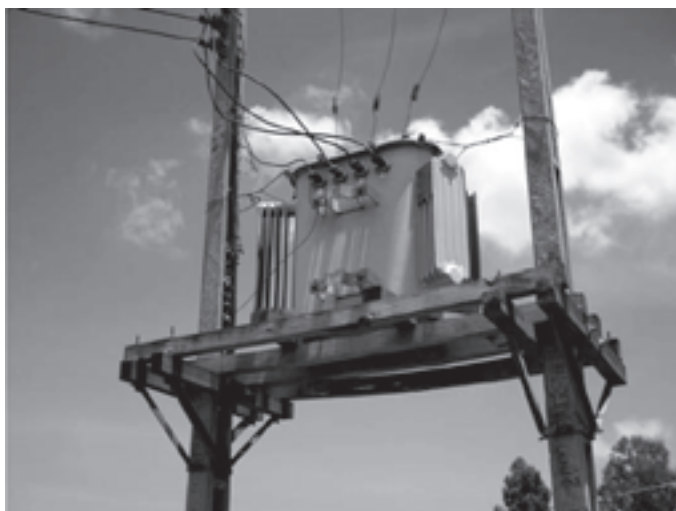
Figura 11 – Subestação em plataforma
