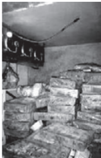
Figura 41 – Mau carregamento da câmara fria
